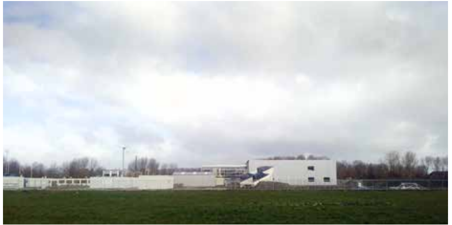
Fase 1 aanbouw van ZAP faciliteit, investering van Hanze Hogeschool en Noorderpoort College
